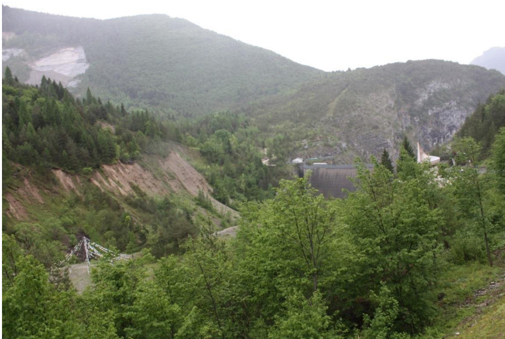
Slika 3: Drsna ploskev (levo zgoraj), odrivni rob plazu (levo) in jez (sredina, desno) v dolini Vajont
