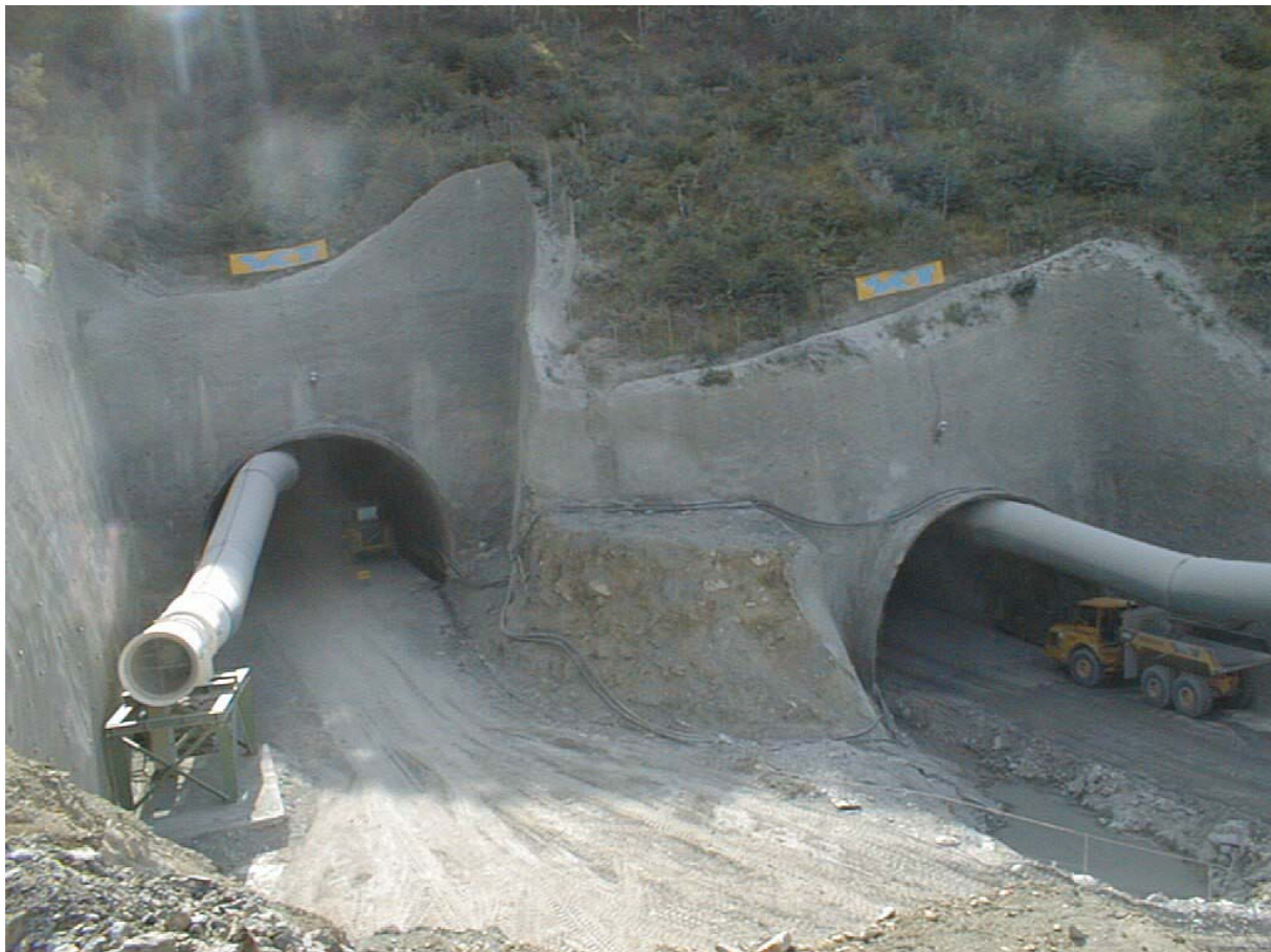
Slika 1. Začasni portal na zahodni strani predora Dekani
