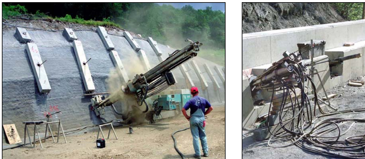
Slika 3. Vgrajevanje in napenjanje sider na odseku HC Razdrto – Vipava.
