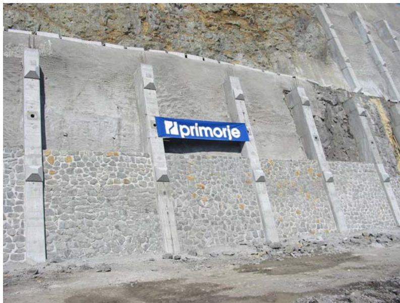
Slika 1. Varovanje brežine s sidranimi slopi na območju MMP Gruškovje
