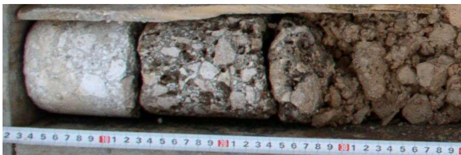
Slika 4: Prikaz betonske ploče izvedene dvoslojno od betona različite kvalitete (polje 10-G)
