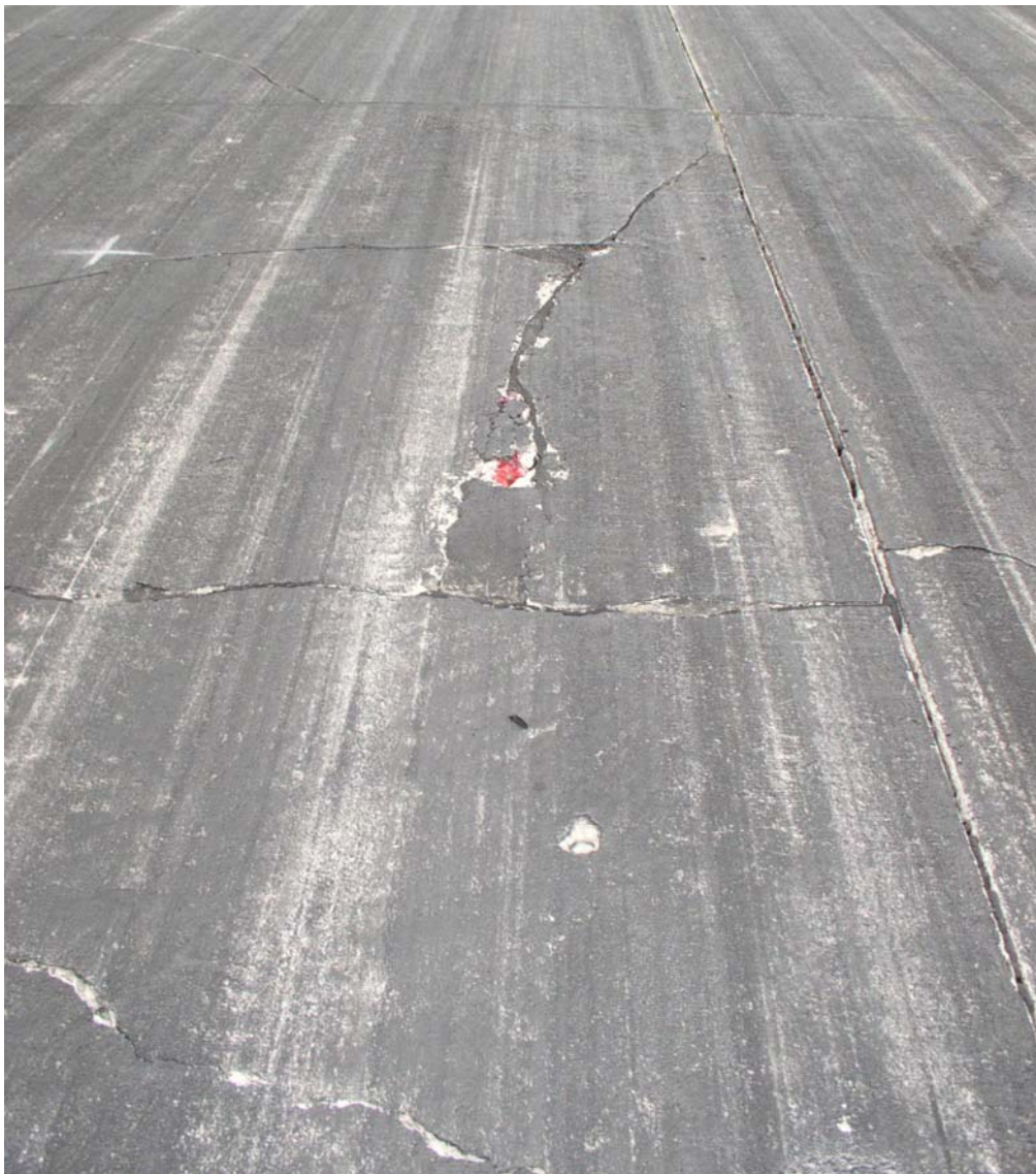
Slika 1: Raspucale ploče u Zračnoj luci Dubrovnik
