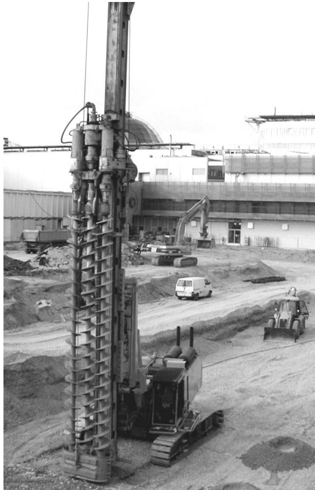
Slika 3. Stroj RG20 s trojnimi vrtalnimi spiralami (polži); izdelava elementov temeljenja
