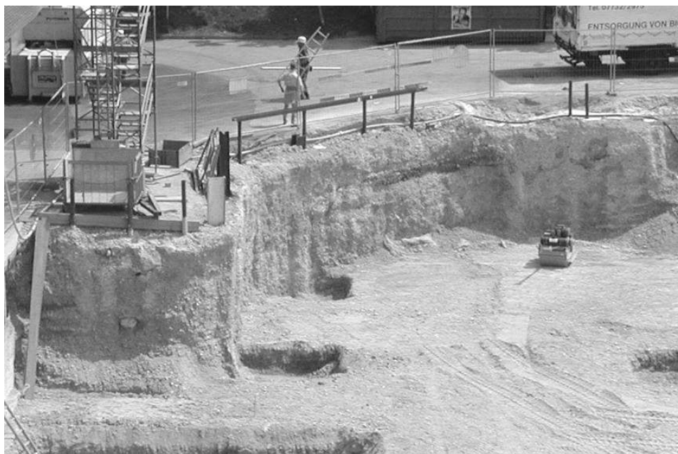
Slika 8: Zaščita gradbene jame iz MIP panelov, armiranih z železnimi profili, na področju dovoza za interventna vozila
