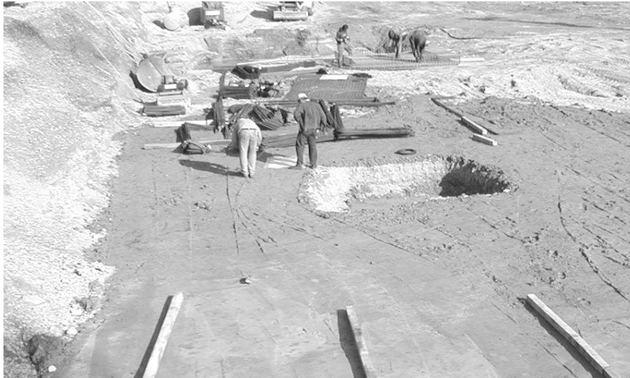
Slika 10. Uporaba navrtanine (mešanice in-situ materiala in cementa) za podložni beton
