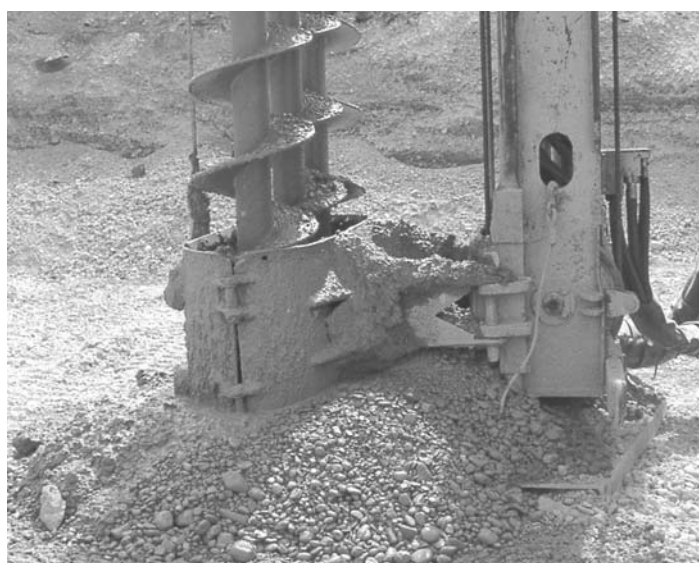
Slika 6. Detajl uvtavanja trojnih spiral; minimalne količine odvečnega materiala MIP postopka
