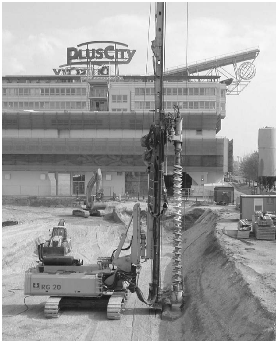
Slika 5. Stroj RG20 s trojnimi vrtnimi spiralami (polži); temeljenje obodnih sten
