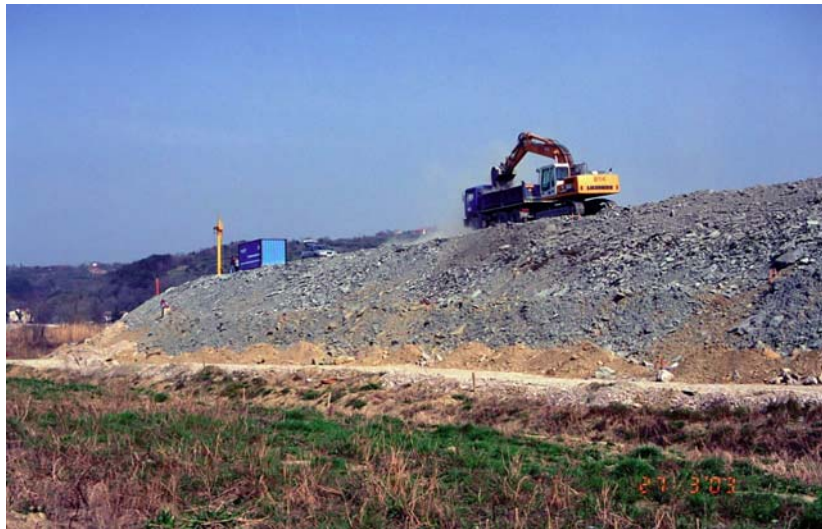
Slika 1. Visoki nasip Srmin na AC odseku Klanec – razcep Srmin med gradnjo
