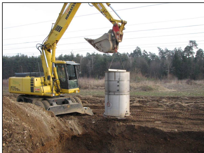
Slika 5: Telo lizimetra - gradnja
