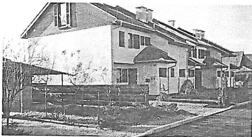
Slika 14. Končni izgled prototipne izgradnje
